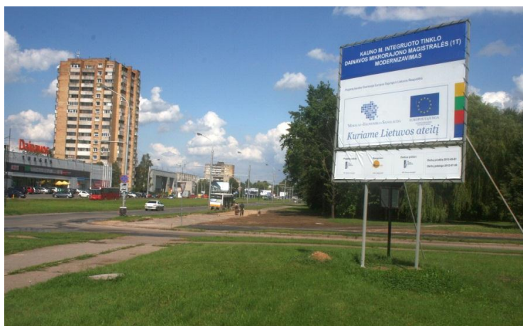
Magistralės 1T atkarpa po rekonstrukcijos.
