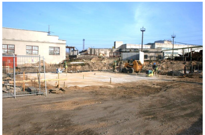
Įrengiamas biokuro sandėlis Petrašiūnų elektrinėje.
